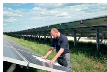
Ingenieur des PI-Berlin überprüft PV Kraftwerk
