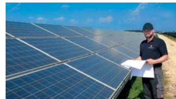
Ingenieur des PI-Berlin überprüft PV Kraftwerk
